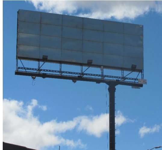
Foto 2. Vista del tablero – O - E
